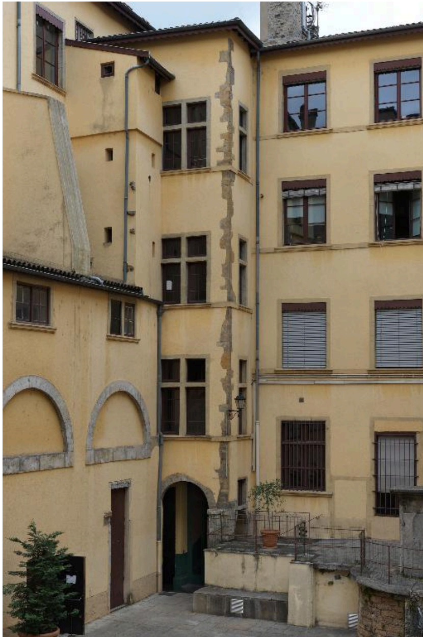
La cage de l'escalier ouest depuis l'immeuble sis 64 rue Mercière
