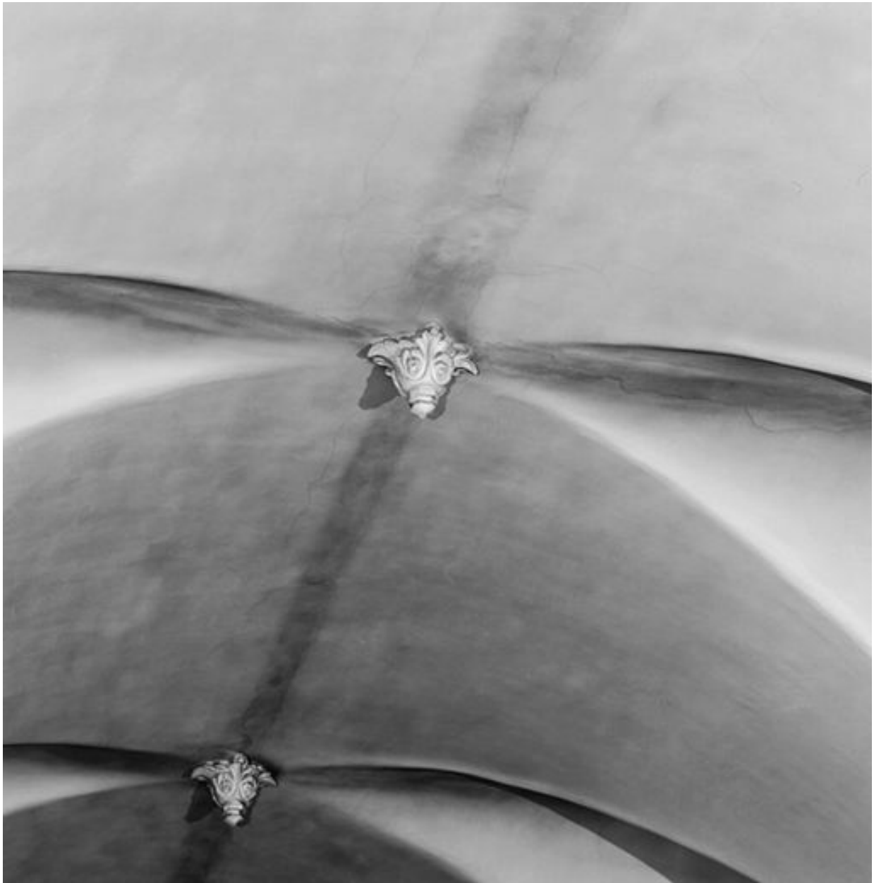
Eglise, détail de la voûte
