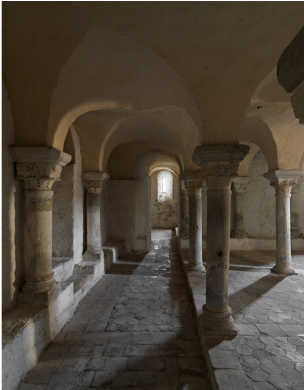
Vue d'ensemble intérieure de la crypte dans l'axe nord-sud, depuis le sud.
