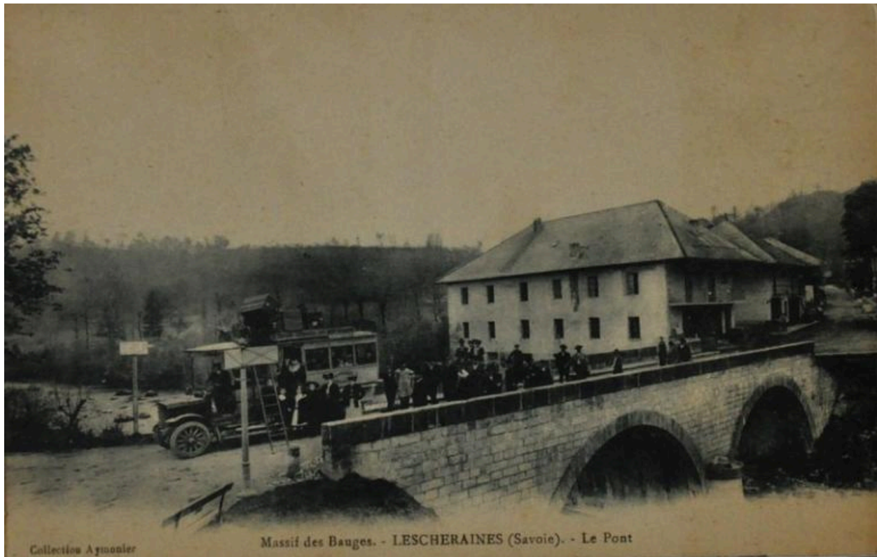
Le pont et le bâtiment de la forge (© Collection particulière M.-A. Podevin).
