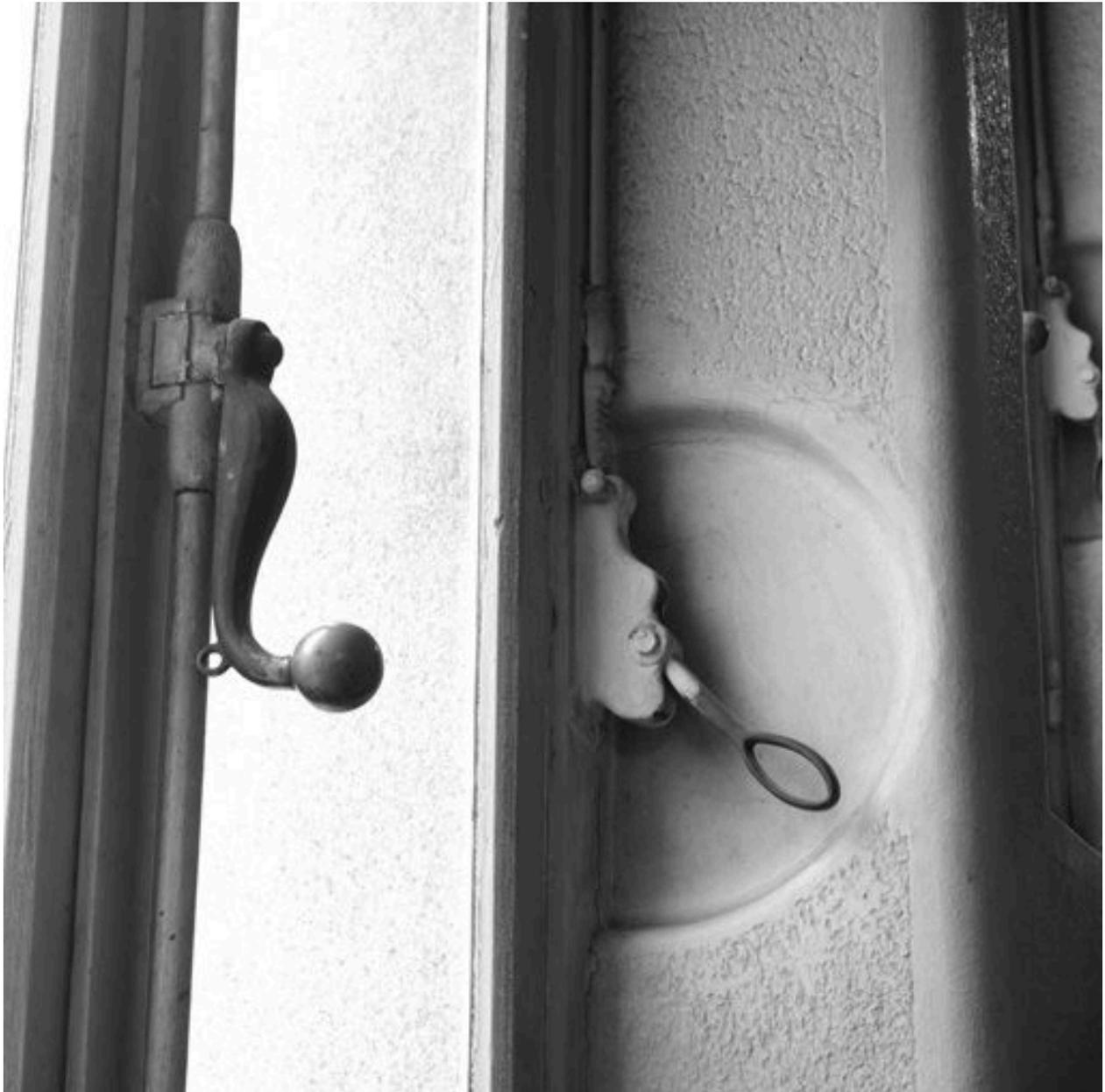
Le bâtiment 18. Détail de la crémone de fenêtre et du système d'ouverture de l'imposte vitrée (escalier)
