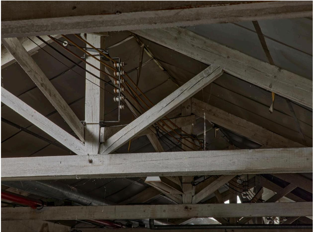
Détail des fermes de la charpente de l'un des bâtiments de l'ensemble F5, jouxtant les pistes d'essais.
