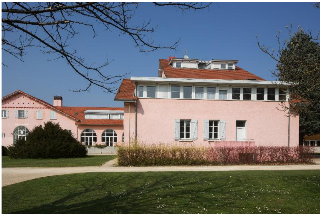
Bât. A : façade latérale de l'aile est avec corps principal
