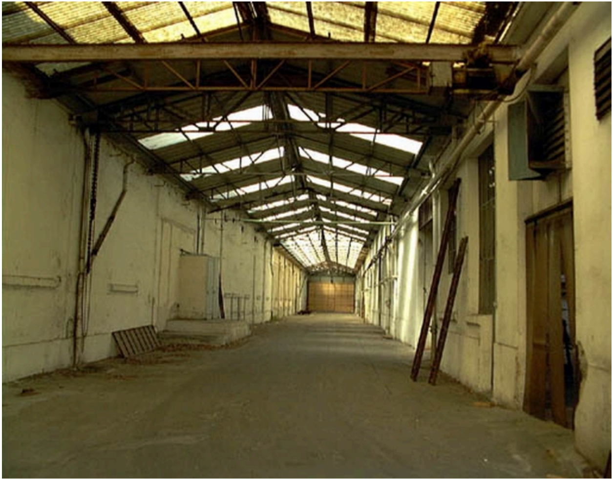
Vue du passage couvert nord-sud
