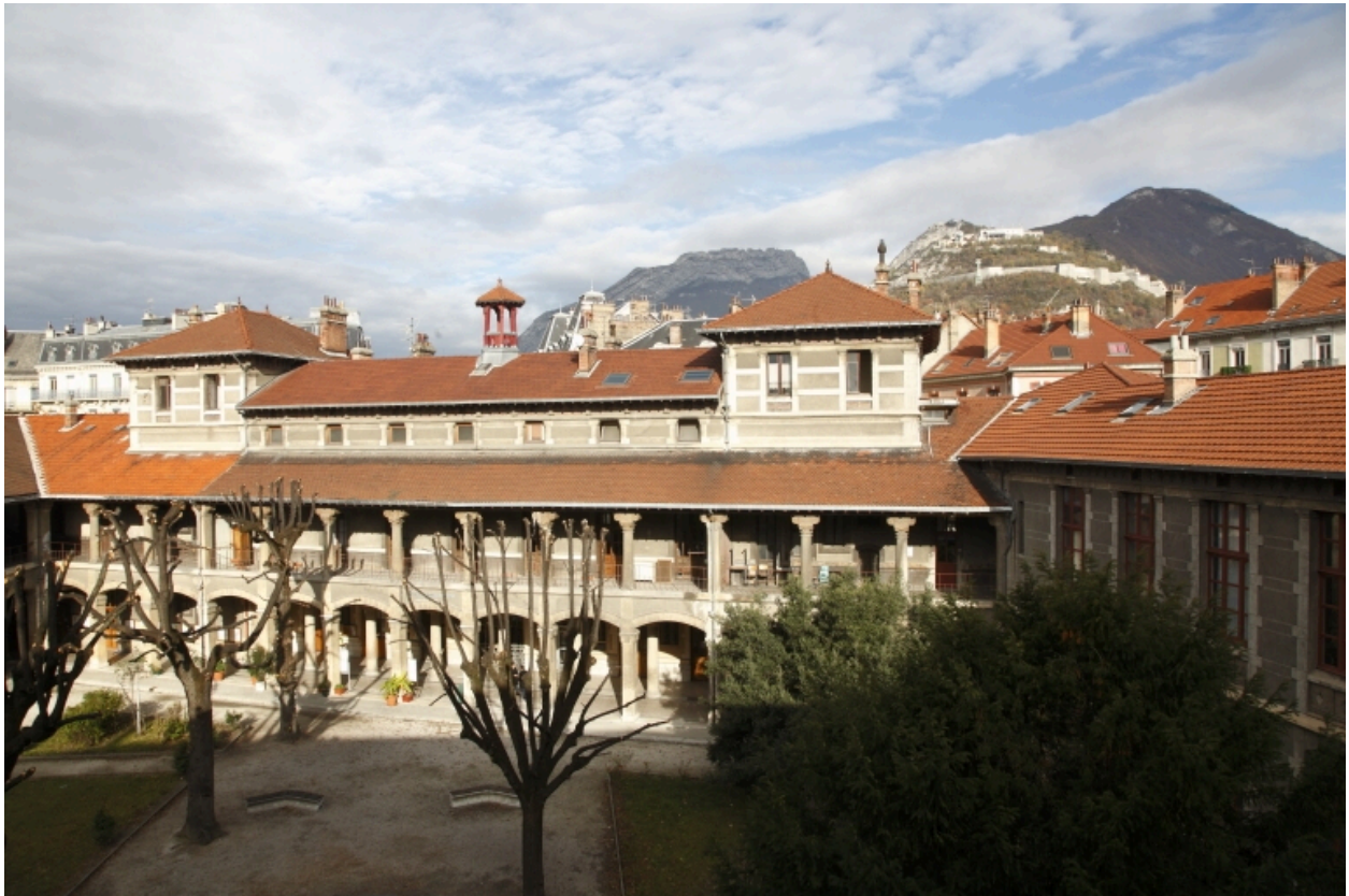
Cour H. Bâtiment d'entrée et corps de bâtiment perpendiculaire.
