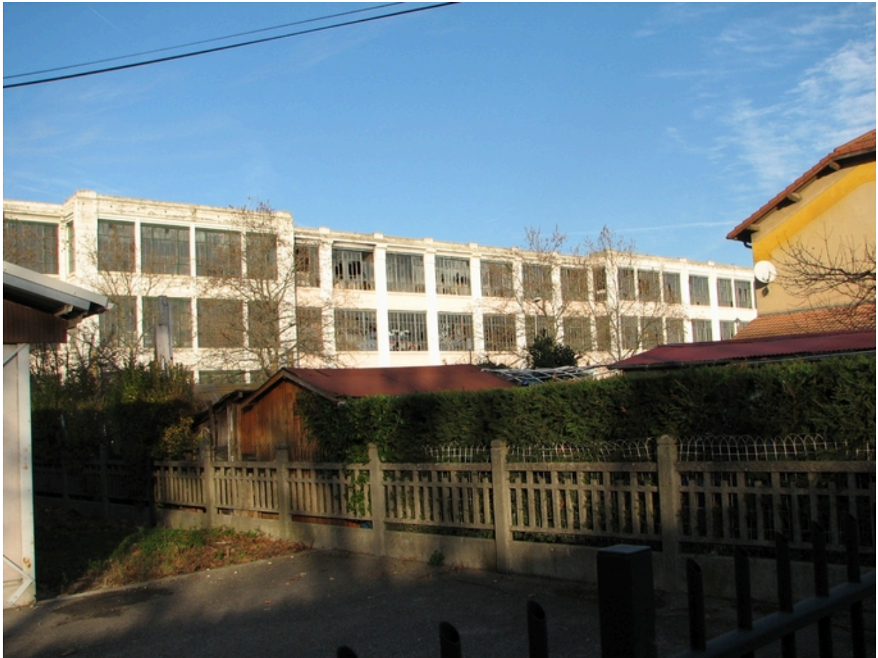
Jardin, abris de jardin, barrière en béton, vue sud-ouest
