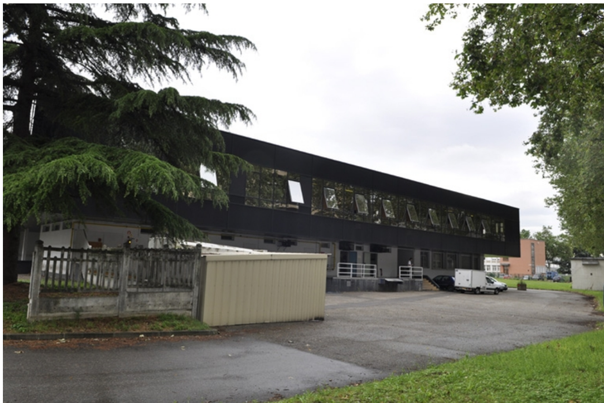
Vue du réfectoire, façade sud.
