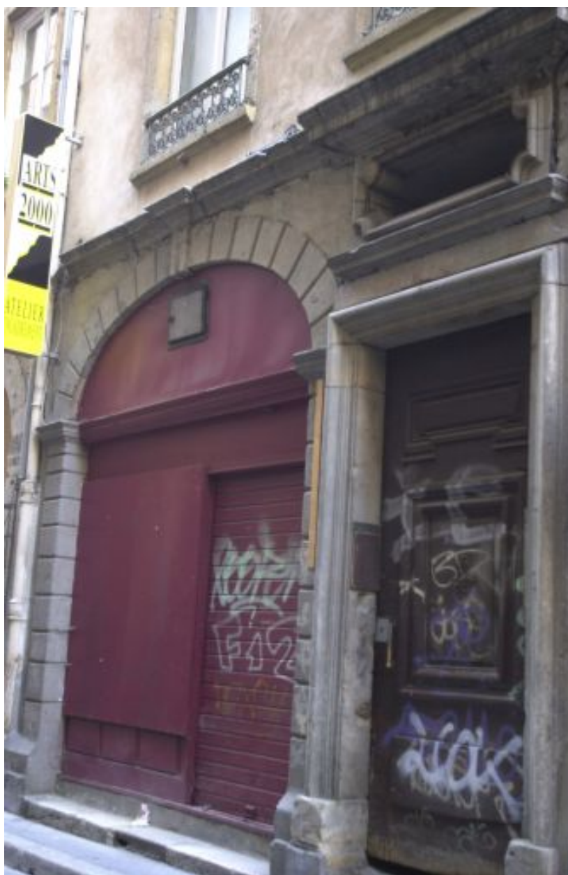
Façade sur rue, rez-de-chaussée
