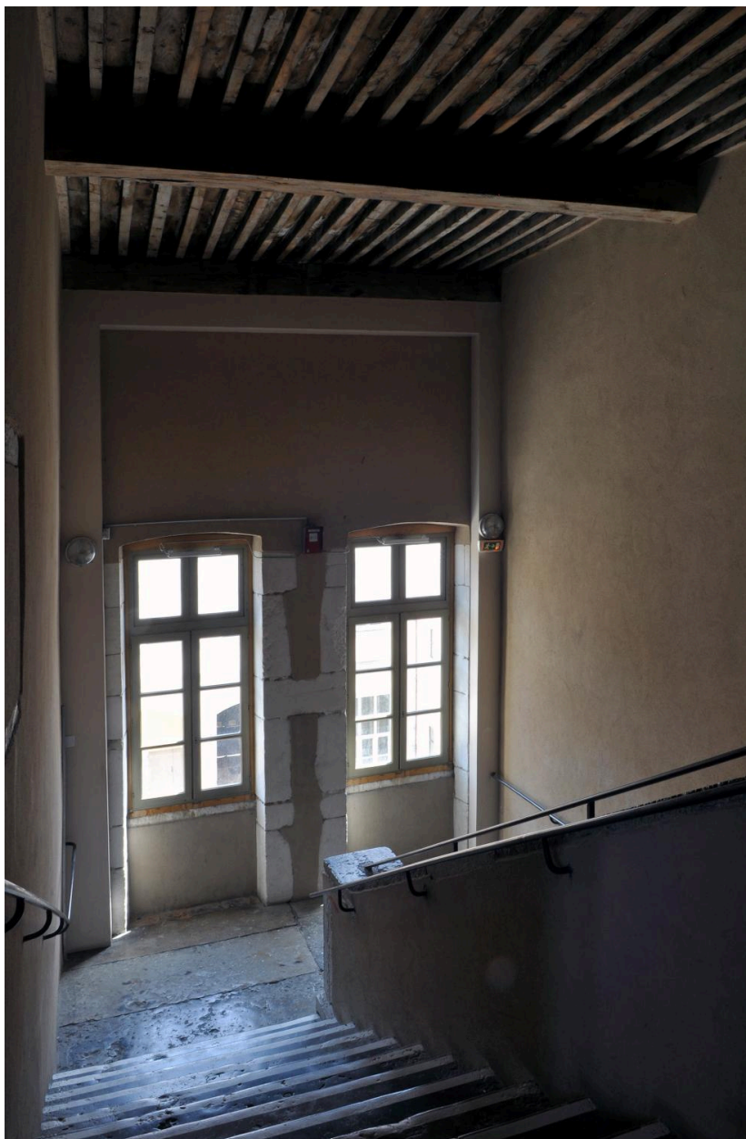
Escalier G : dernière volée, vue depuis le palier du 2e étage
