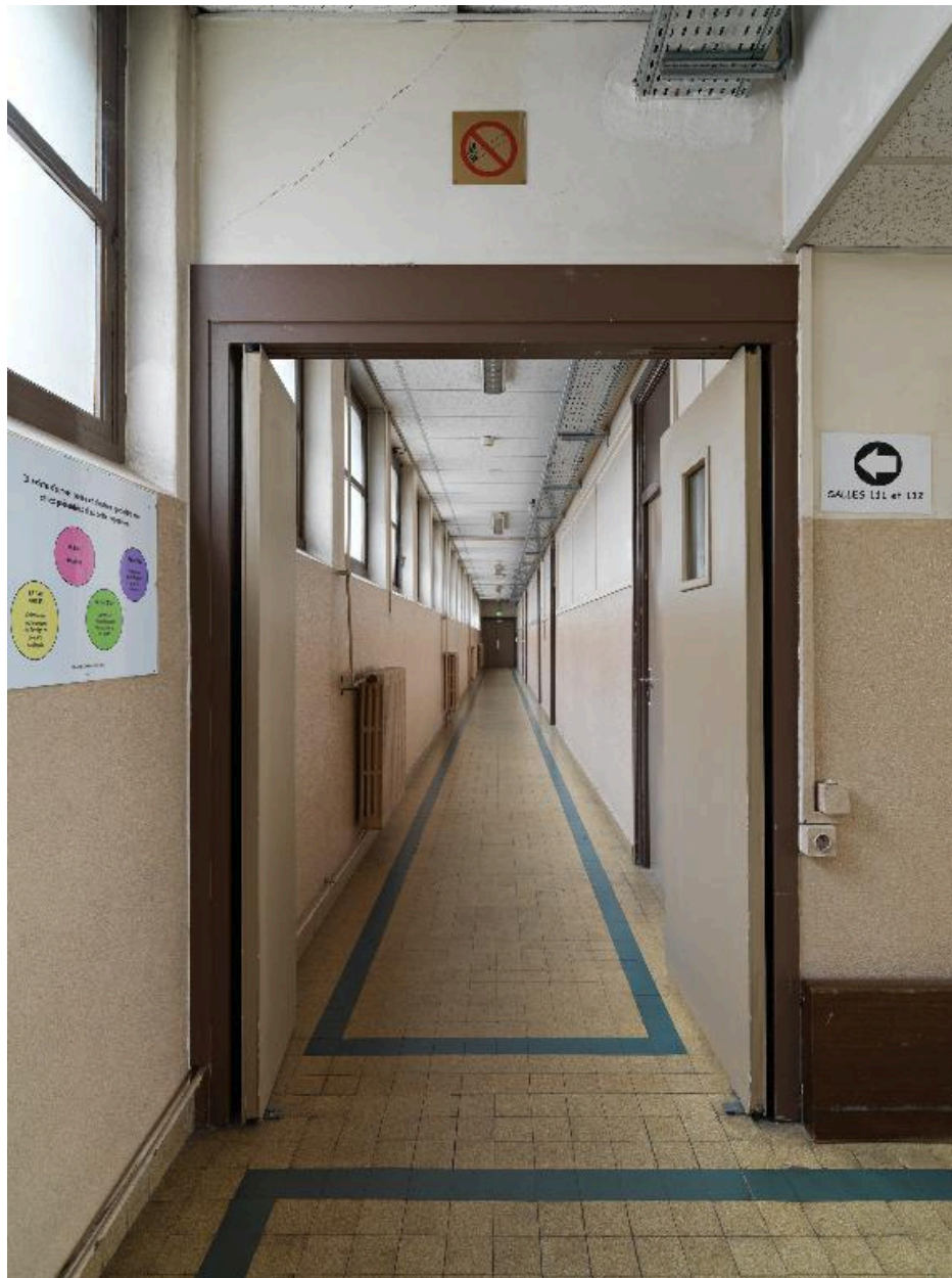
Bâtiment rue Duhamel, couloir du 1er étage, depuis l'ouest
