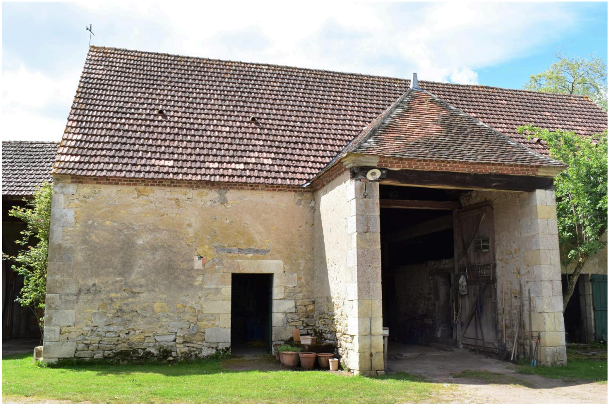
Détail de la grange à auvent.
