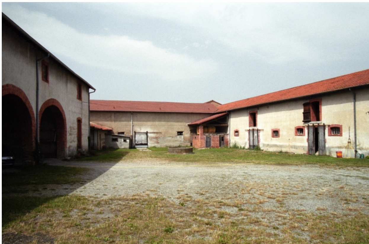
Vue d'ensemble de la cour depuis l'est.
