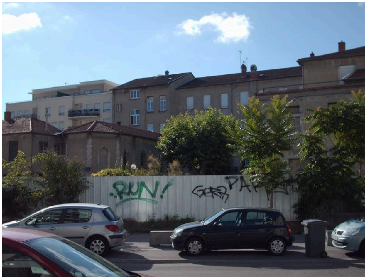
Elévations rue du 24-mars-1852 : vue de situation
