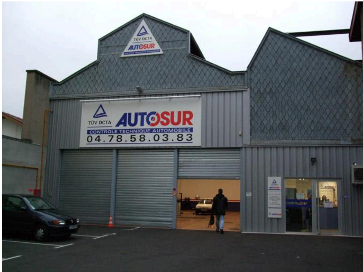
Vue d'ensemble façade ouest
