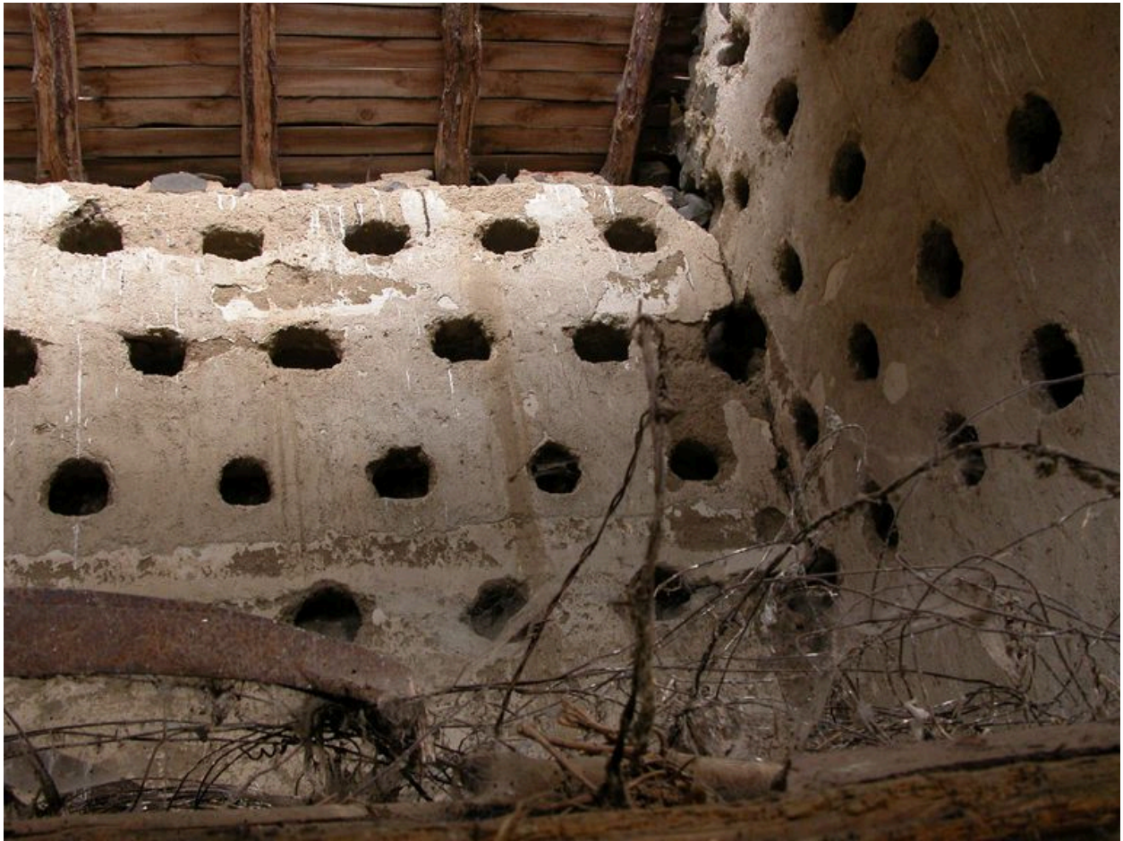
Vue intérieure : trous de boulin.
