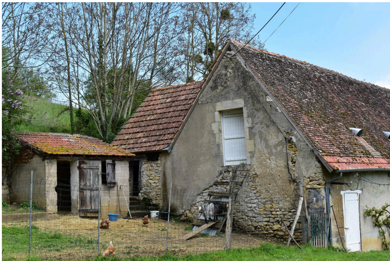
Pignon occidental de la maison-bloc avec aile en retour au nord.
