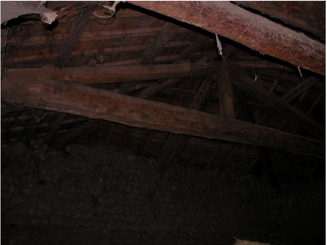
Charpente du passage couvert-cuvage.
