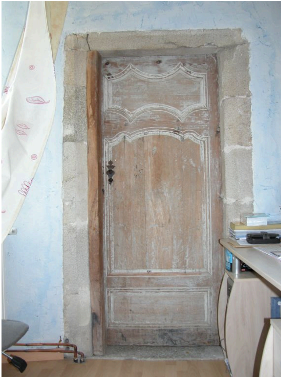
Aile nord de la maison forte, seconde pièce de l'étage carré située à gauche de la cage d'escalier centrale : vue d'ensemble extérieure de la porte à encadrement mouluré ouvrant dans la tour d'angle nord-ouest.
