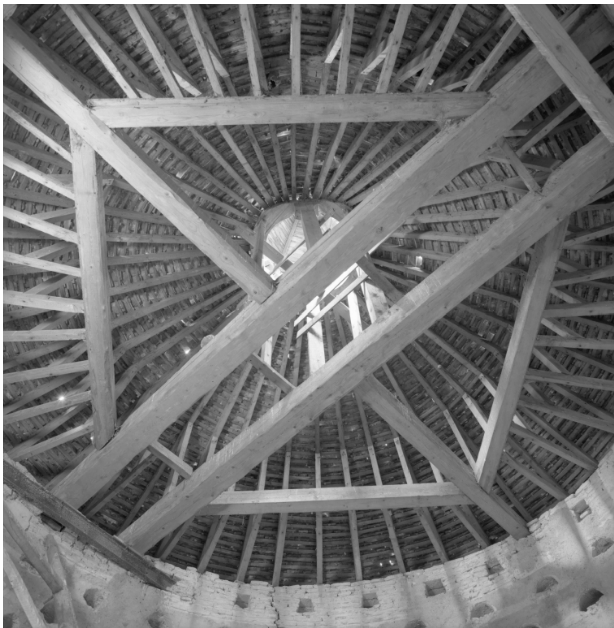
Vue intérieure de la charpente du colombier.
