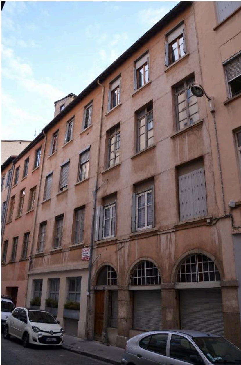
Vue d'ensemble n°2 et 4
