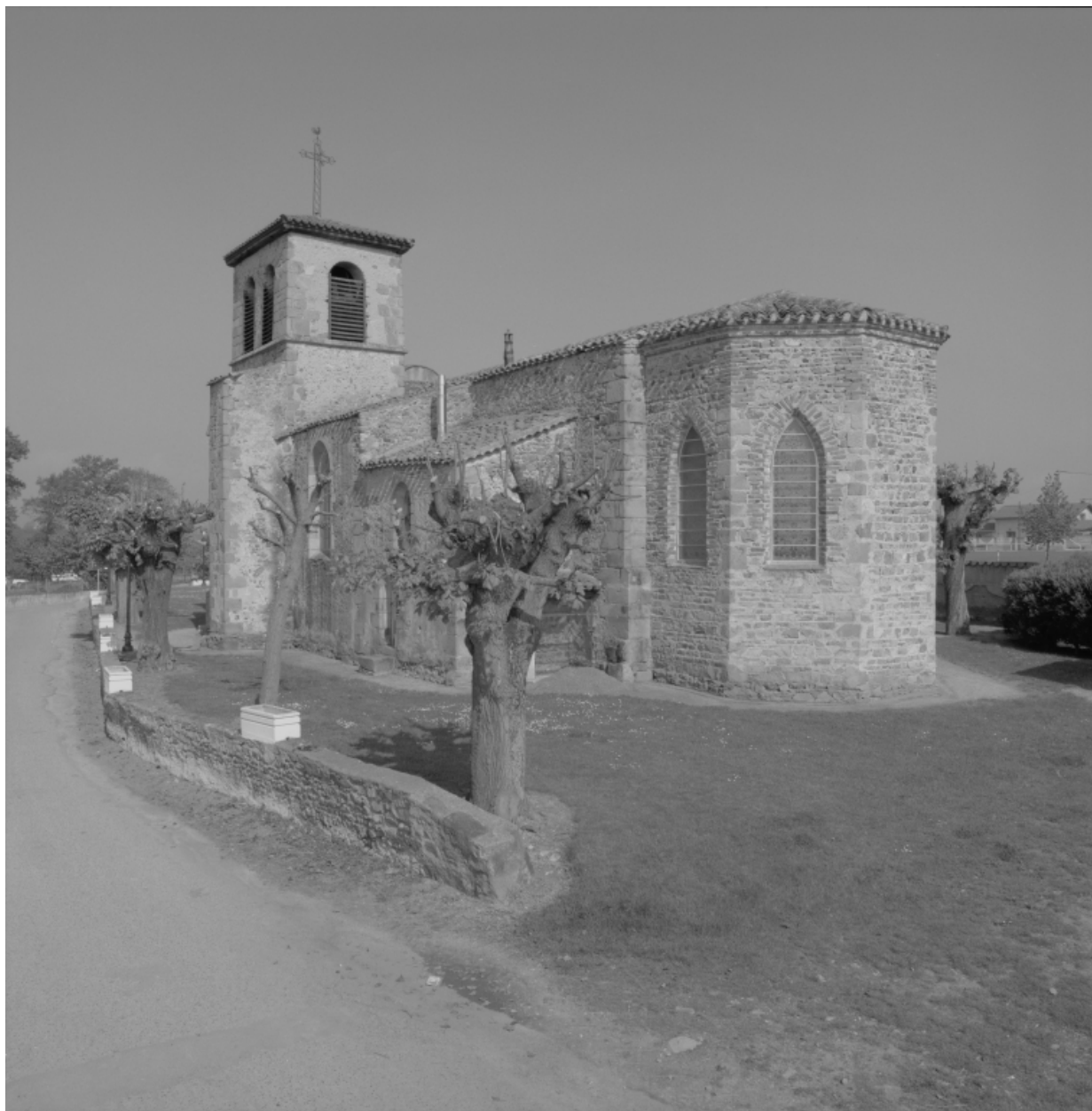
Vue générale de trois-quarts sud-est.
