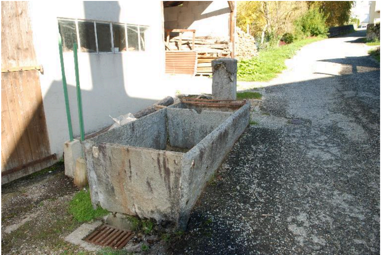
Chef-lieu, bassin en pierre, (non cadastré) vers 2014 B3 1169. Vue d'ensemble.
