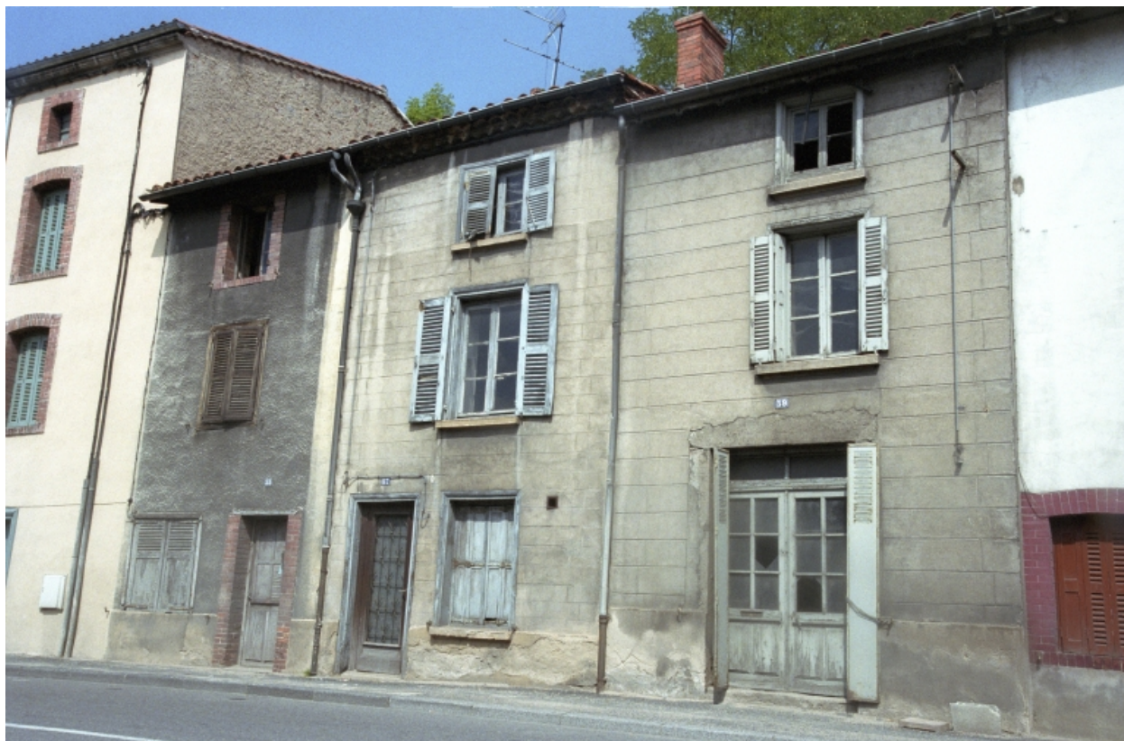
Boën, îlot 17, Lyon (rue de) 59 et 57 et 55. Vue générale de la façade sur rue.
