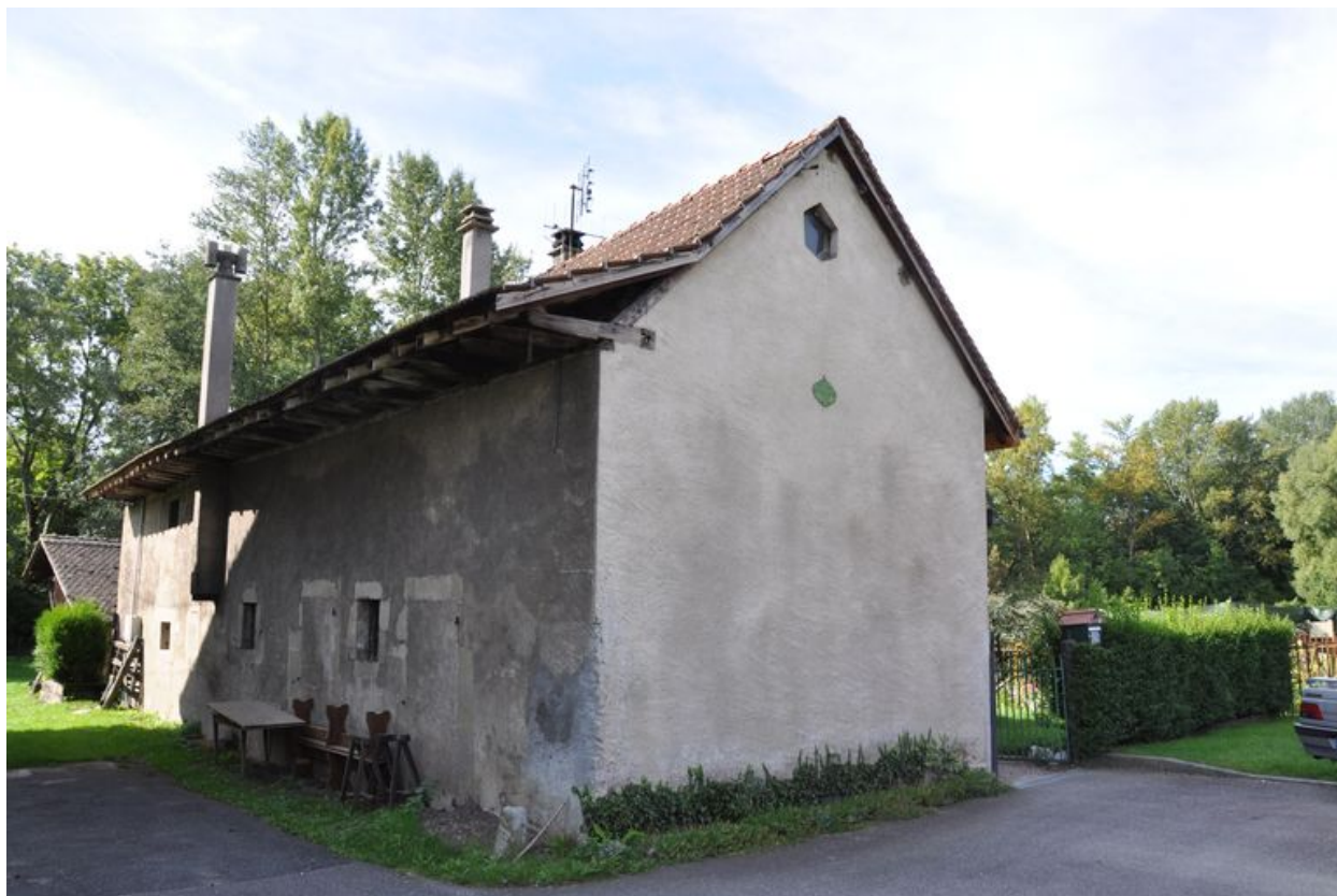
Elévation nord-est du bâtiment de la remise
