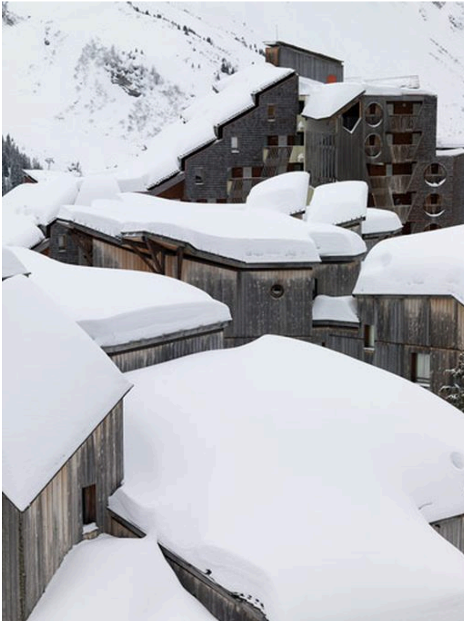
La station sous la neige
