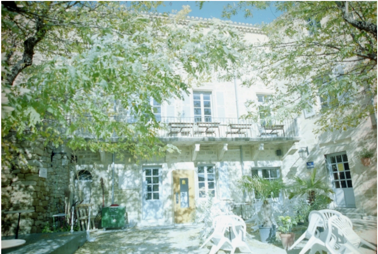
Élévation principale sur cour, donnant sur la place Saint-Louis.
