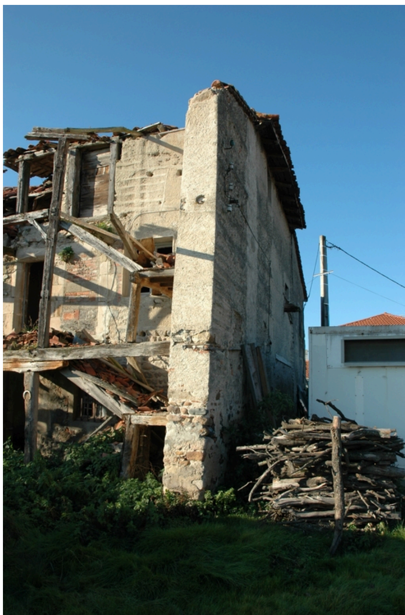
Vue de l'angle nord-est et du mur nord du logis, depuis l'est (état en 2006).
