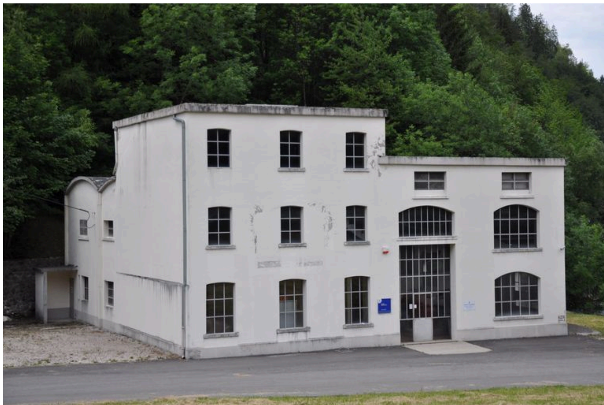
Façade antérieure du bâtiment des bureaux adossé au bâtiment des machines
