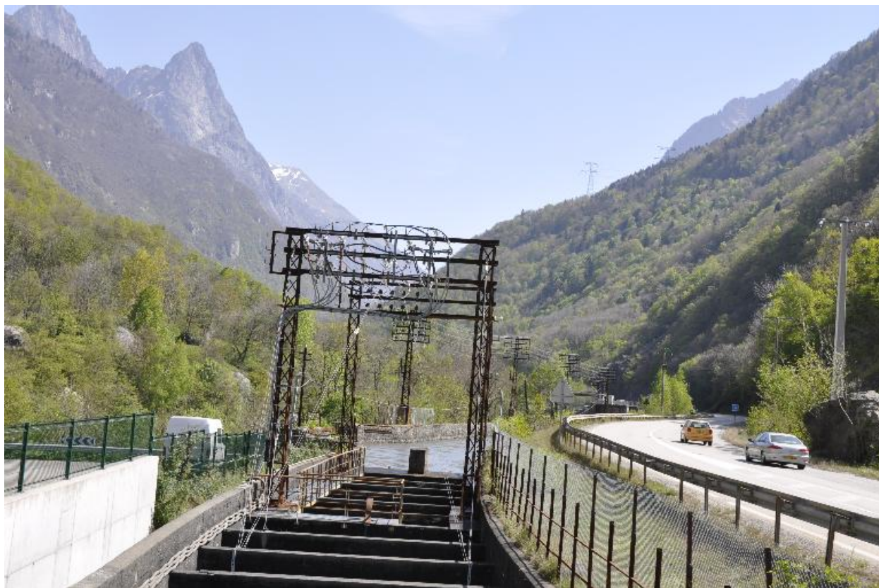
Vue du barrage et de la route
