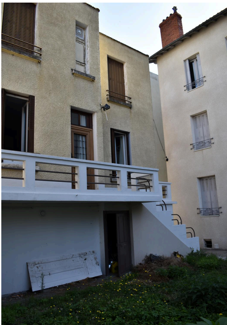
Elévation de l'immeuble en fond de parcelle
