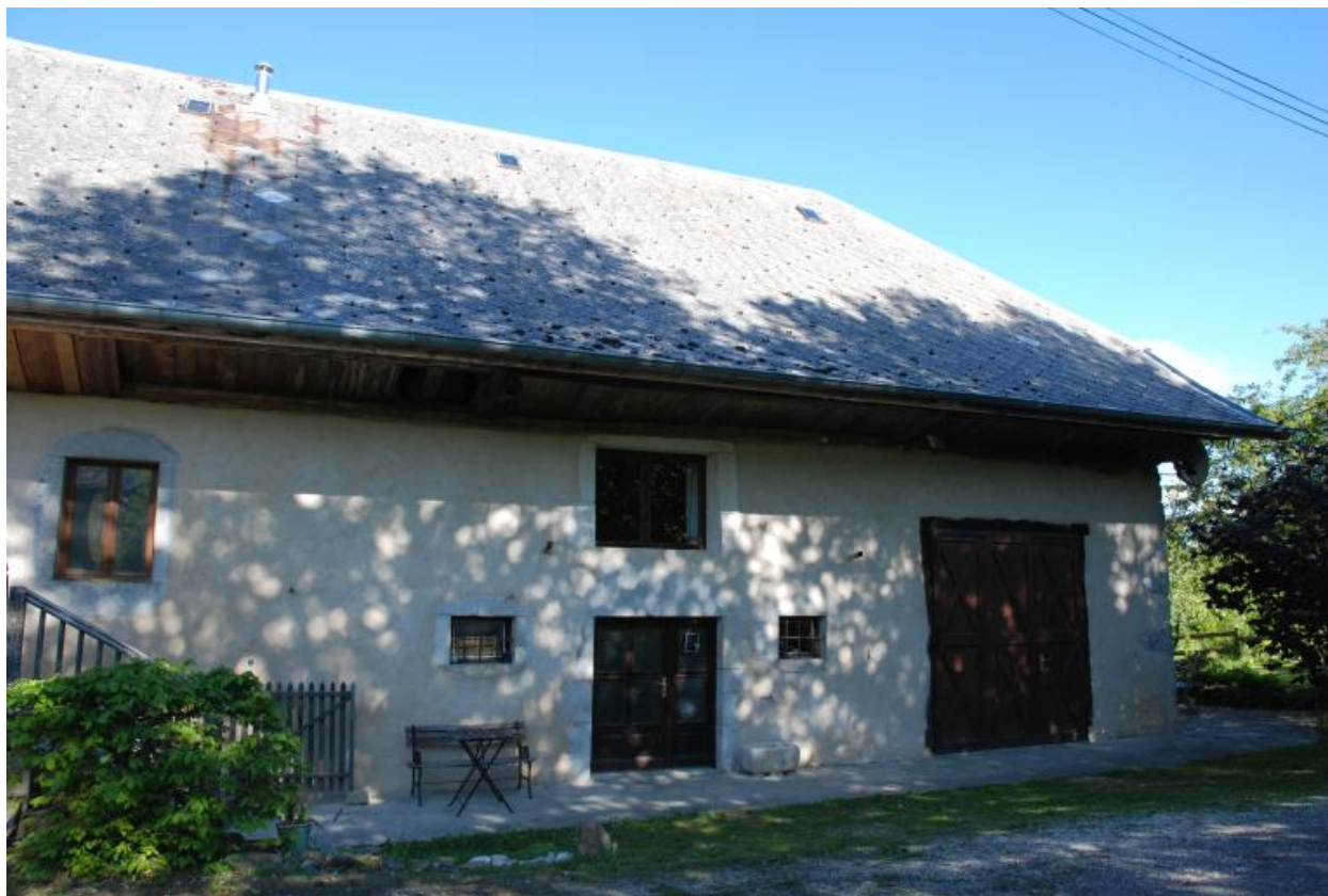
Vue d'ensemble (façade ouest).
