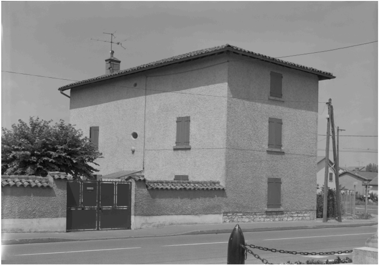
Maison de type V, Jassans-Riottier, 1352 rue Edouard Herriot : maison individuelle en pisé, construite en 1870.
