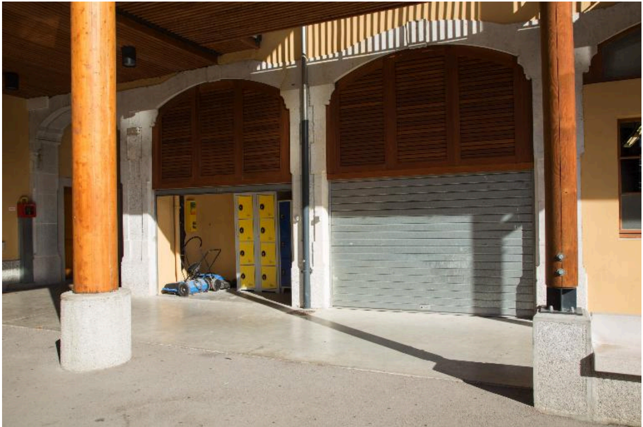
Cour 2 : façade bâtiment est, arcades sur rez-de-chaussée.
