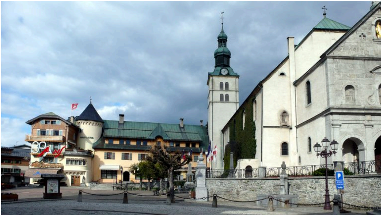
Vue depuis le sud
