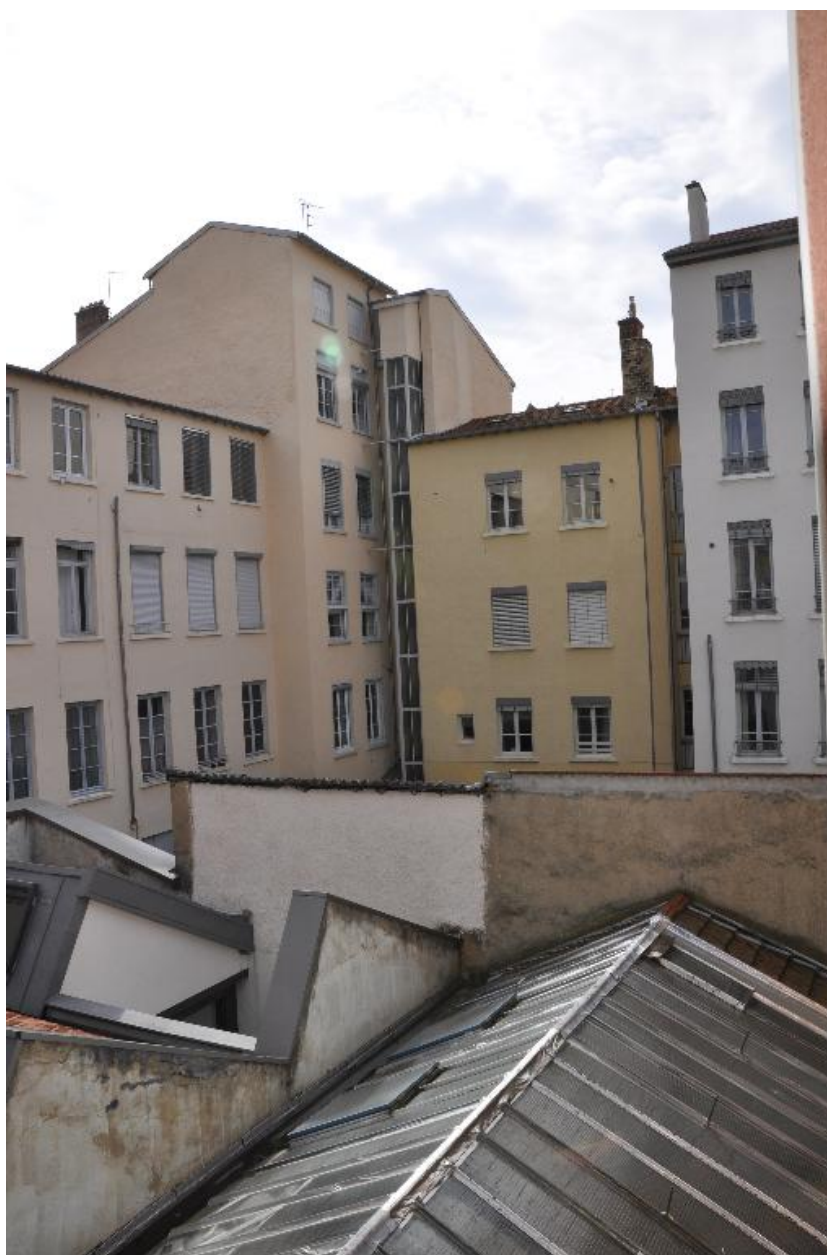
Vue nord ouest de l'immeuble d'angle
