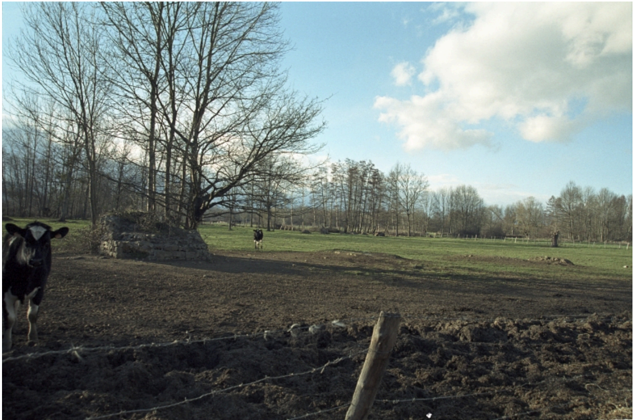
Vue des restes des piles du pont sur le Lignon, à Mérizat (Montverdun ? ZB 79).
