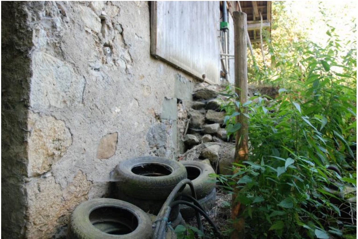
Vue du bâtiment annexe : ouverture latérale.
