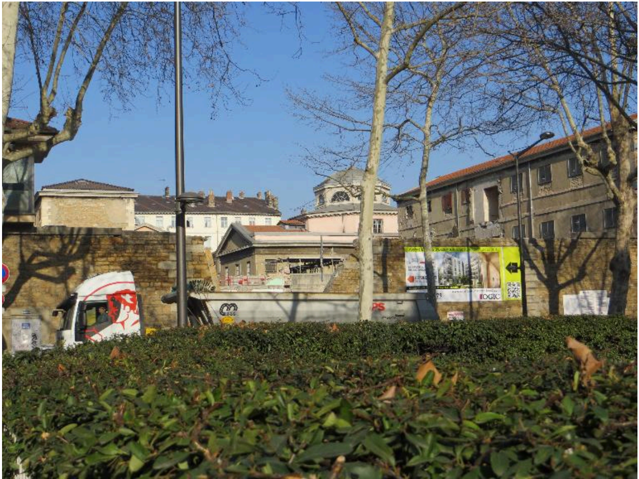
Etat au 19 février 2013 : vue générale depuis le cours Suchet
