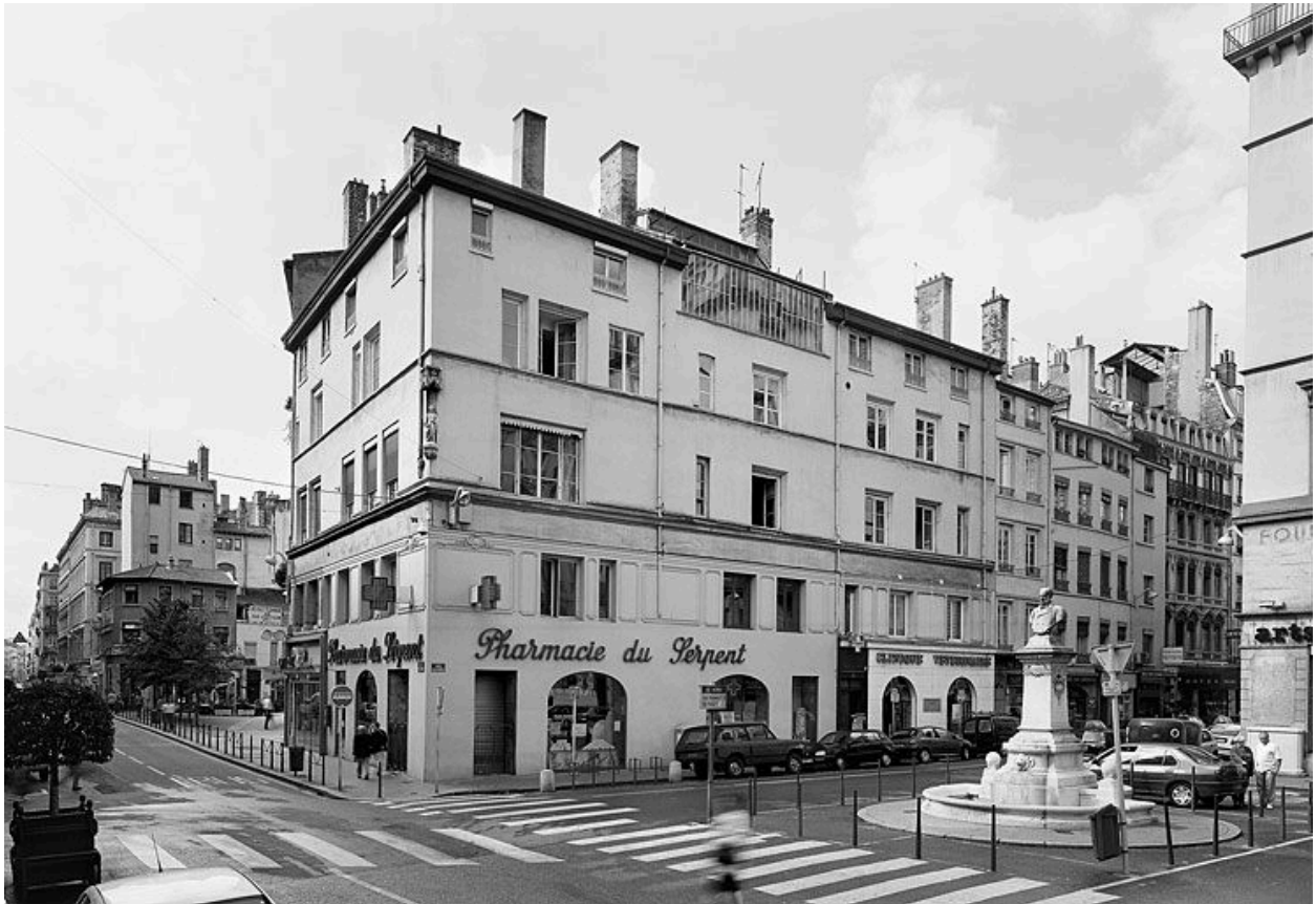
Vue générale des façades
