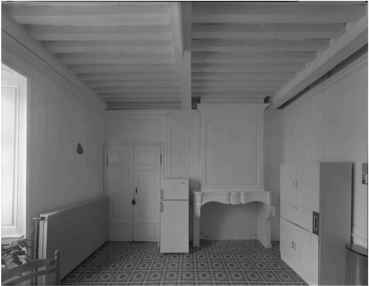
Vue intérieure de la chambre n°1, à l'étage, vers la cheminée.
