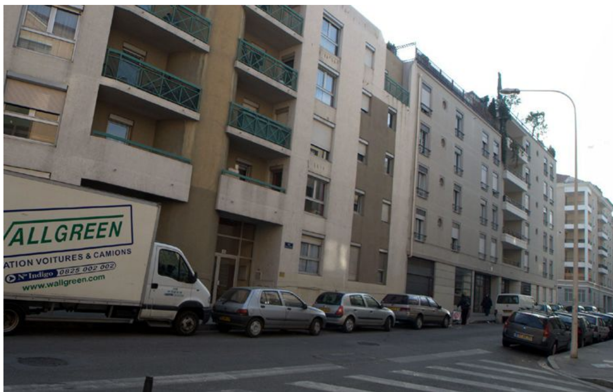
Elévation antérieure, vue partielle
