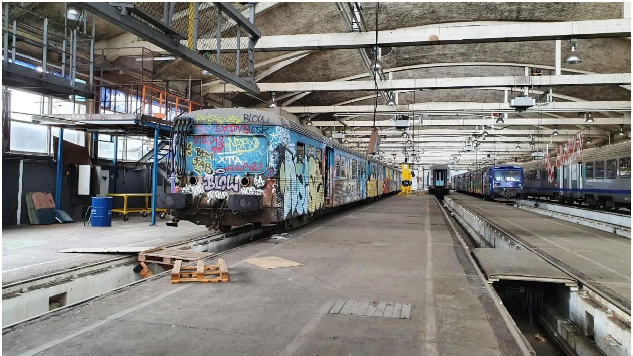
Détail charpente en béton
