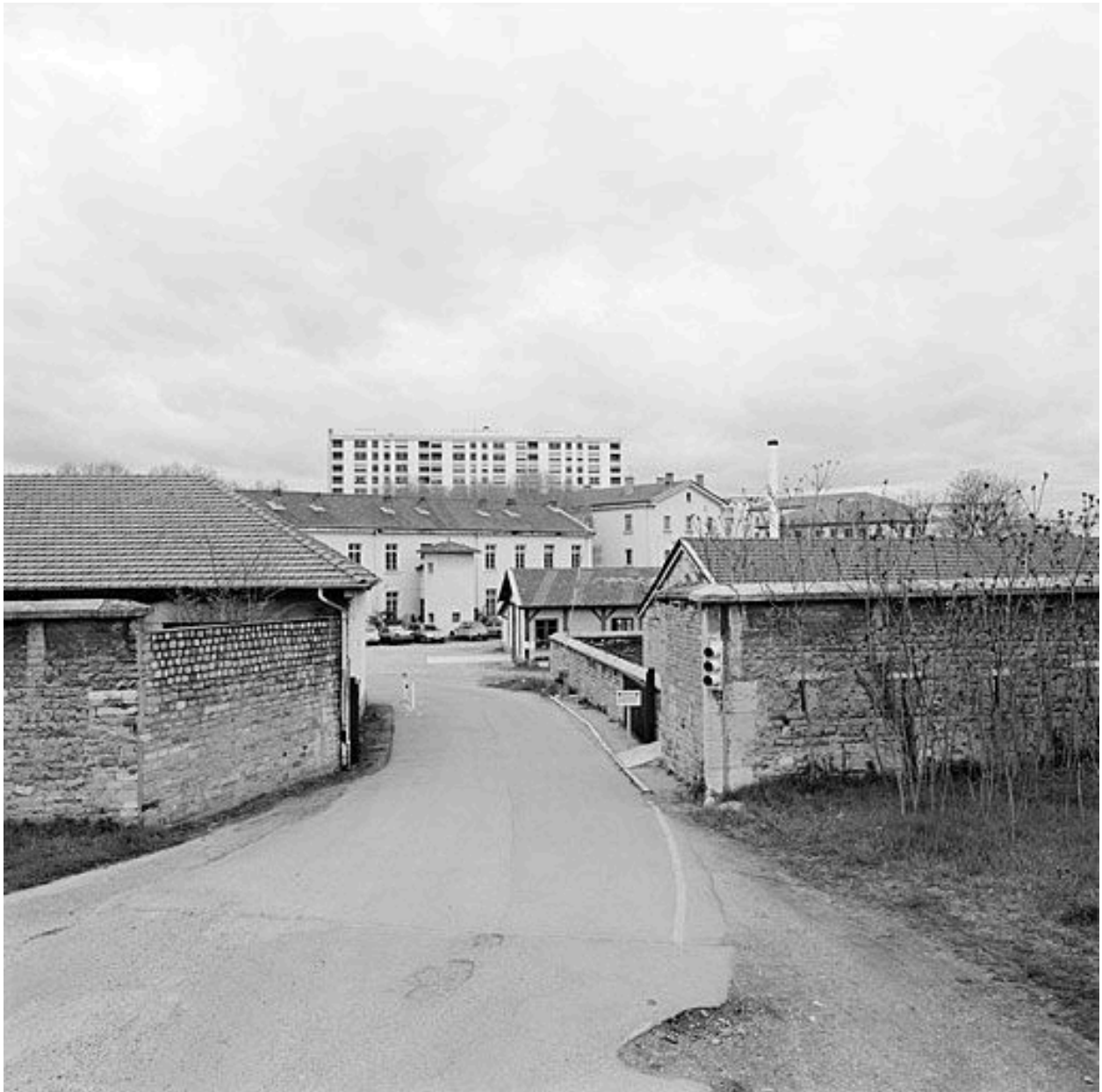
Entrée secondaire rue Victorien Sardou
