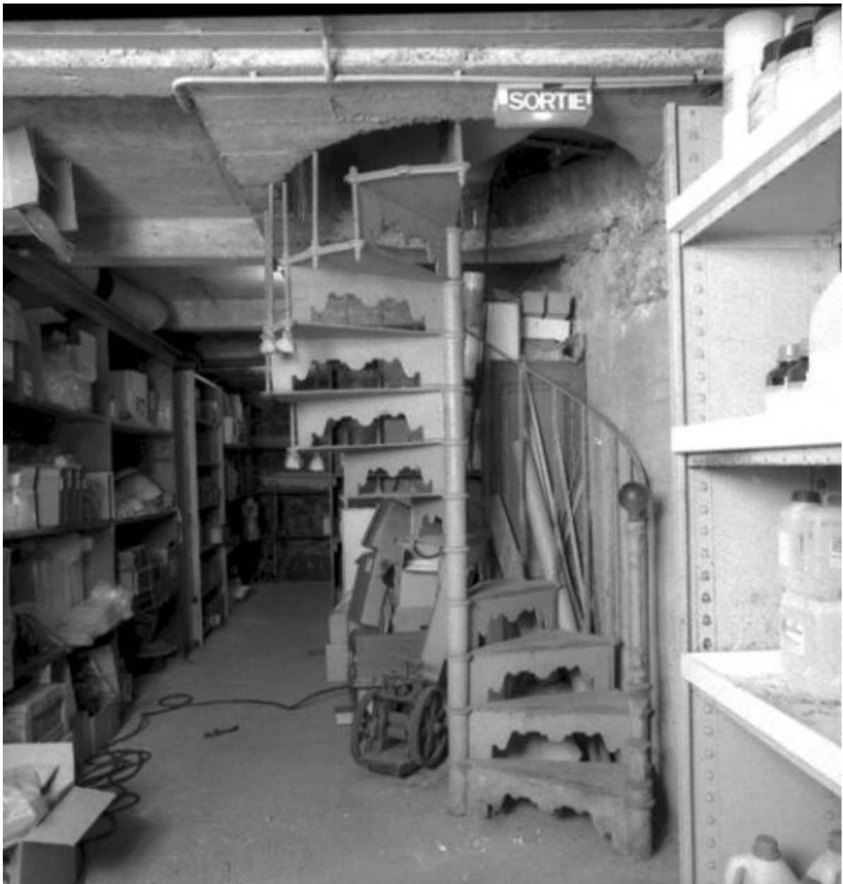
Cave nord desservie par un escalier en fonte de fer
