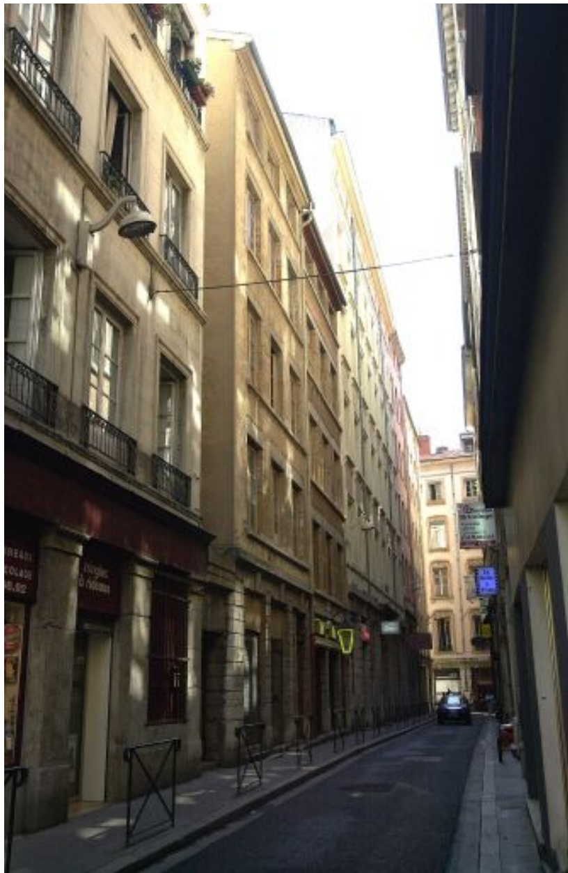
Façade principale sur la rue Lanterne
