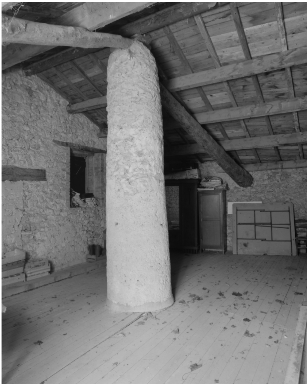
La Mège. Comble, pilier soutenant la charpente.
